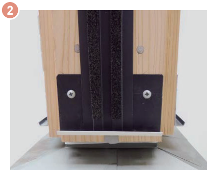
▲接合部用部材をモエン用釘または専用ビスで留め付ける
