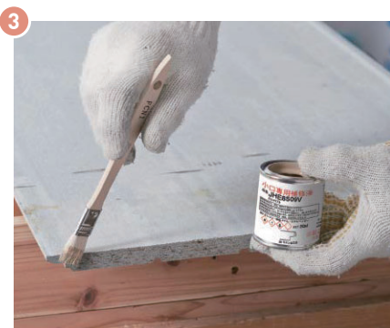
▲モエン切断小口面を補修塗装する
