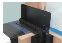
図2 スポットルーツの取り付け
