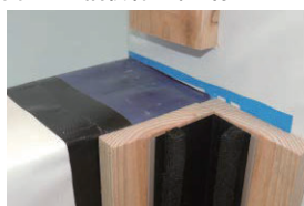
図1 入隅役物の取り付け
