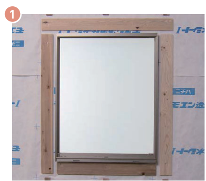
▲開口部まわりに胴縁90サイズを施工する
