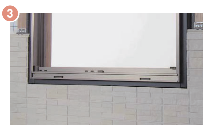
▲開口下はスペーサーを入れ、モエン用釘で固定する
