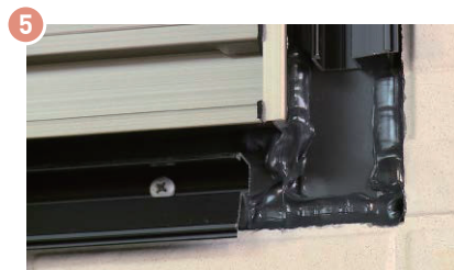
▲開口角部（4ヵ所）に捨てうちシーリングを施工する
