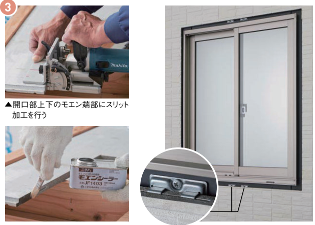
図4 開口部上下の施工
