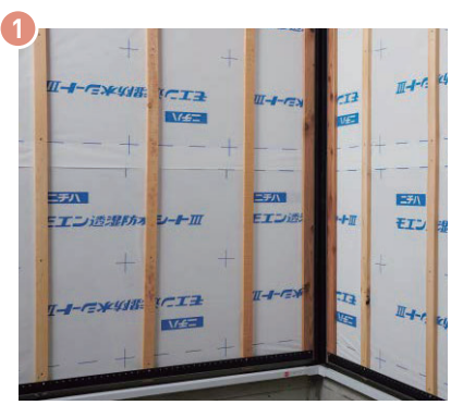
▲鋼板入隅材をモエン用釘または専用ビスで留め付ける
