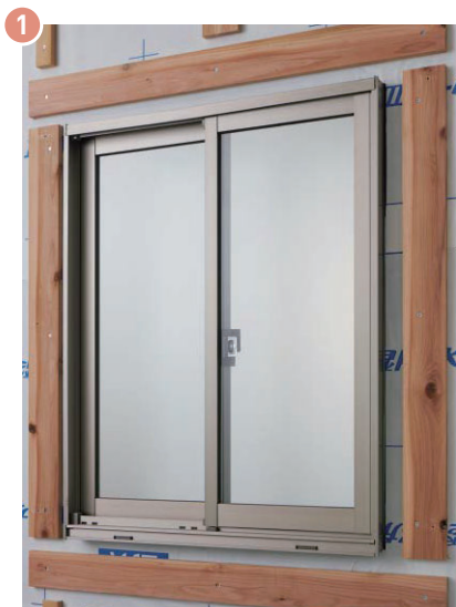
▲開口部まわりに胴縁90サイズを施工する
