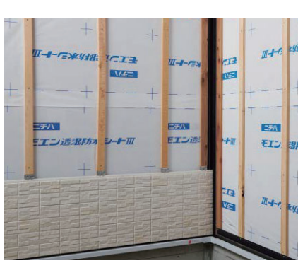
▲留付金具EXで先施工モエンを施工する
