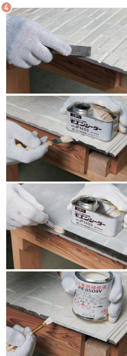
▲モエン加工部を補修塗装する
