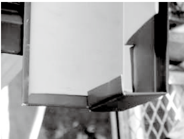
けらば水切110(85)軒先部の加工例
