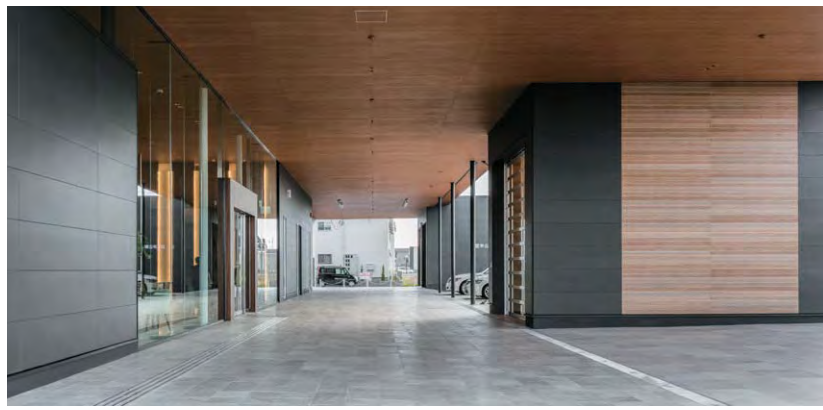
右の納車セレモニーが行われる壁面を、Fu-geのモセルウッドとCOOLのメモリアで張り付けている。
