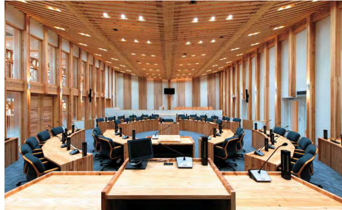
釘を一本も使用せず船底を表現した天井が美しい、新庁舎2階の議場。
