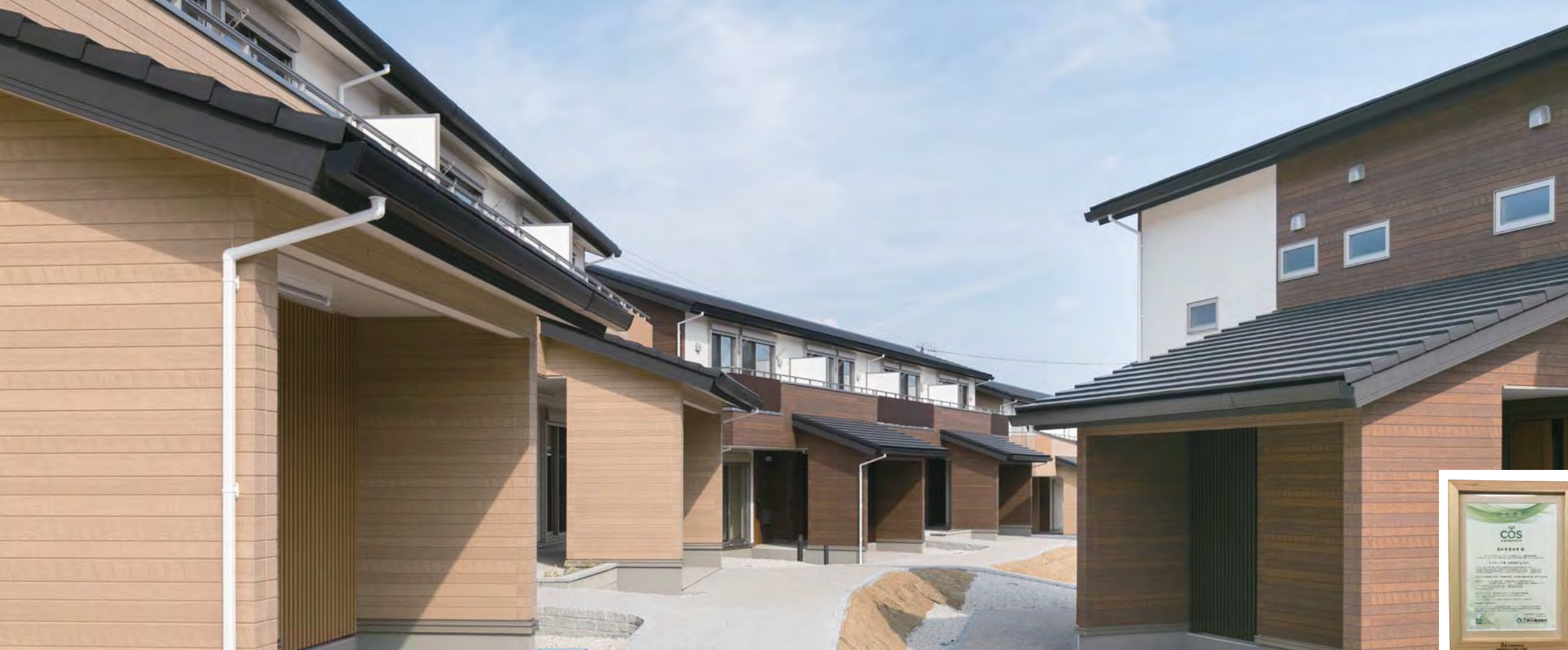
外壁材には、1Fの木目柄にFu-geのカルナウッド、グレーシアンアッシュMGとミディアムブラウンMGを、2Fに同じくFu-geのプリレート、クアラMGホワイトを使用。色数を抑え、玄関やバルコニーの手摺りの色味も外壁に合わせたことで、すっきりとした統一感のある外観に仕上げています。
