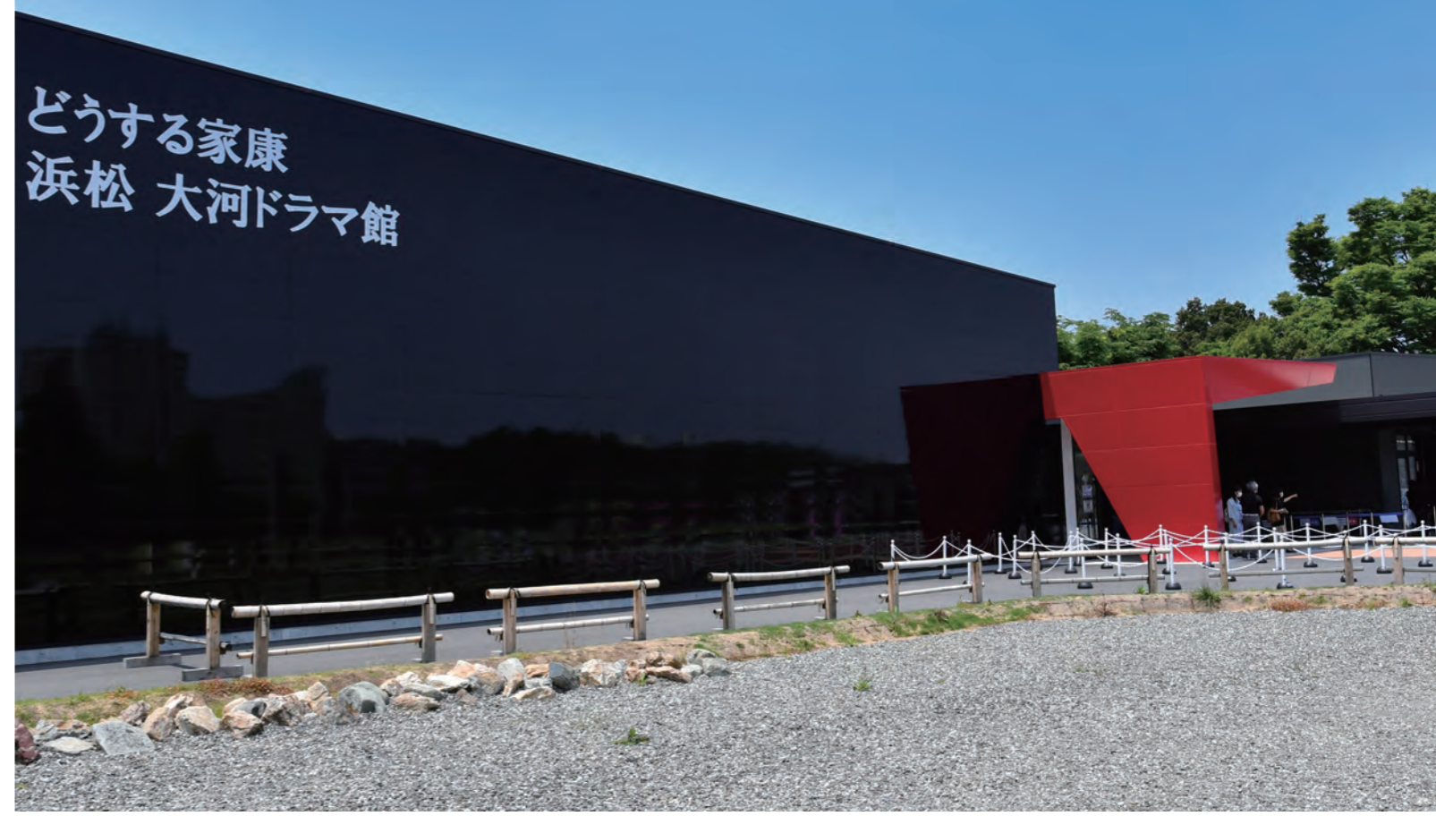
ミライア ピアノブラックが全面張りされた大河ドラマ館本館。光沢のあるミライアが、浜松の主要産業の一つであるピアノをモチーフに選定されました。建物の出入口は、浜松城の本丸裏門があったとされる位置に配置。写真の赤い部分は焼失してしまった以前の浜松城本丸の裏門があった場所だそうです。
