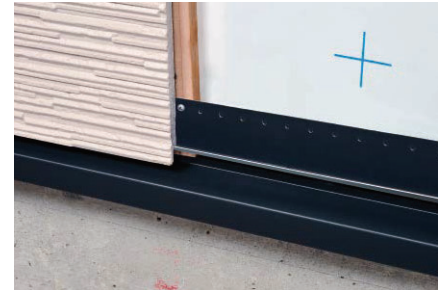
横張り金具工法の土台部 (FA150A)
