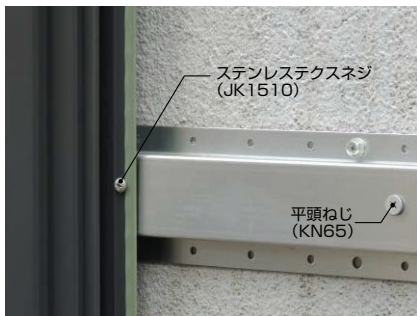
ステンレステクスネジ(JK1510)を使用し、センターサイディングを留め付けてください。
