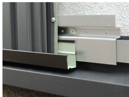
土台部には金属胴縁15接合部用(KN2060)を使用して施工してください。
