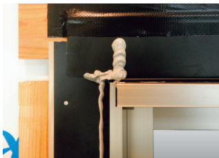
鋼板止水部材・防水紙に15mm以上重なるように貼る
