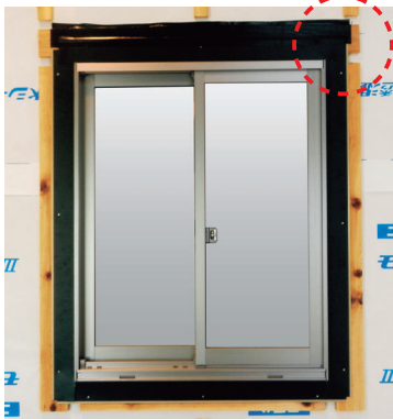
鋼板止水部材・防水紙に15mm以上重なるように貼る
