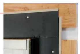
サッシ横に取り付けた部材の上に重なるよう施工
