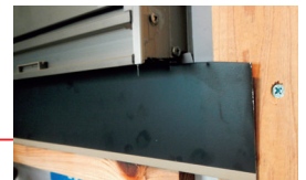
鋼板止水部材をサッシ面に押しつけながら胴縁に留め付けます
