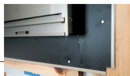
サッシ下に取り付けた部材T字部に被るよう留め付けます
