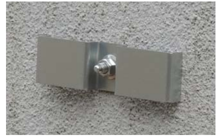
RC用アンカーを使用し、金属胴縁15アタッチメント (KN70) を固定してください。
