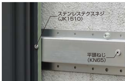
ステンレススクリュー (JK1510) を使用し、センターサイディングを留め付けてください。
