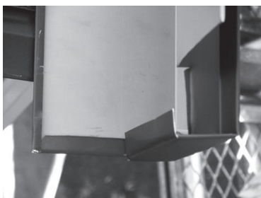
けらば水切85軒先部の加工例
