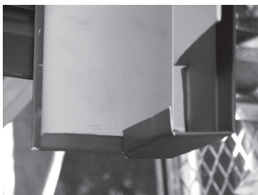
けらば水切85軒先部の加工例
