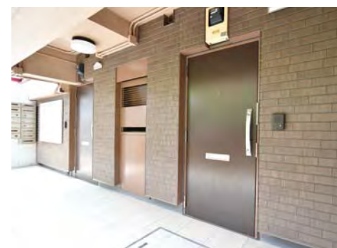
1階廊下のリフォーム後の壁面。「玄関ドアも新調され、エントランスから一步入ると、まるで新築のように感じた」と、施工後の印象を樋口様は振り返ります。
