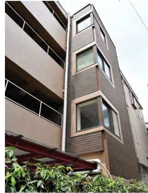
通路側北東面の外観。廊下の手すり壁は、外壁と色を変えて、リシン吹付けの塗装が施された。
