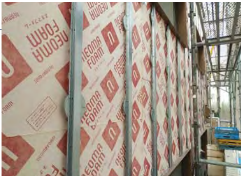
断熱材の施工後、不陸調整用のベースディスクが取り付けられ、その上に金属胴縁が施工されている模様。（基本構成や断面図はP5参照）
