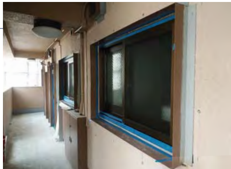
サッシや玄関ドア、メーター、換気口まわりに、加工された金属製のL型役物が施工されました。
