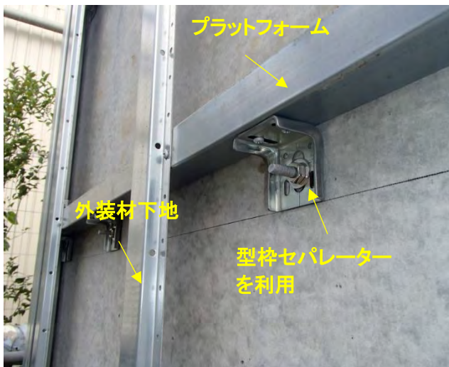
鋼製下地（プラットフォーム）詳細
