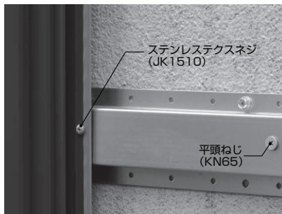
ステンレススチースネジ (JK1510) を使用し、センターサイディングを留め付けてください。
