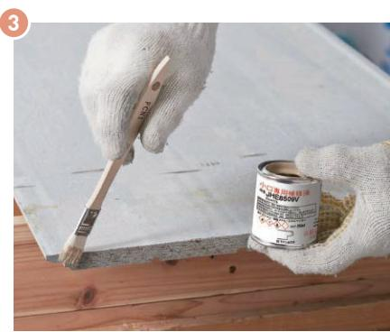
▲モエン切断小口面を補修塗装する
