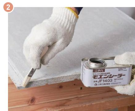
▲モエン切断小口面にモエンシーラーを塗布する(2回塗り)
