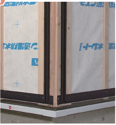
▲接合部用部材をモエン用釘または専用ビスで留め付ける
