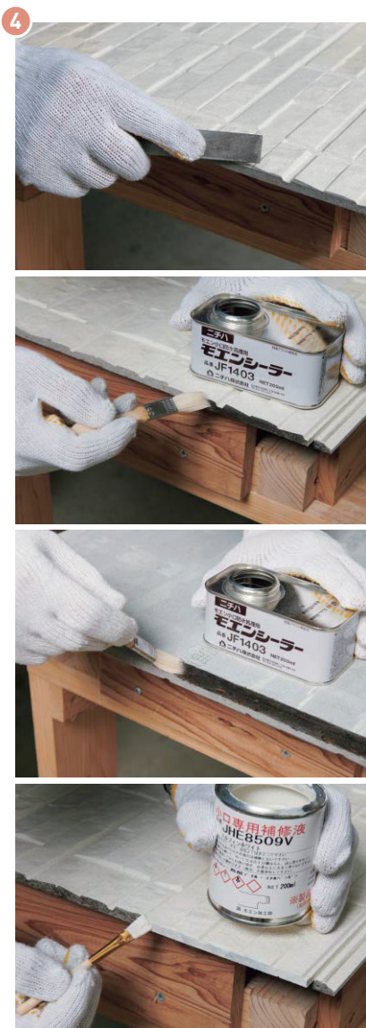
▲モエン加工部を補修塗装する
