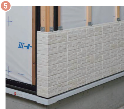
▲留付金具EXでモエン本体を施工する
