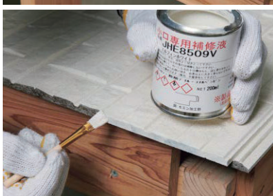
▲モエン加工部を補修塗装する
