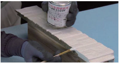
▲同質出隅に面取り加工を施し、補修塗装する
