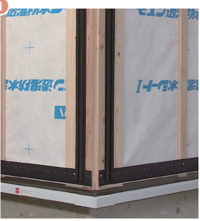
▲接合部用部材をモエン用釘または専用ビスで留め付ける
