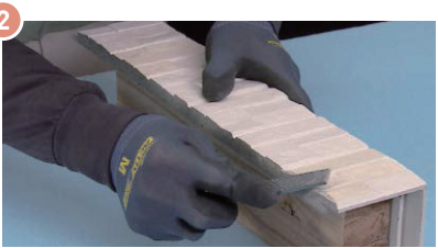
図2 同質出隅小口部の補修塗装
