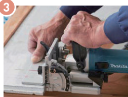
▲開口部上下のモエン端部にスリット加工を行う
