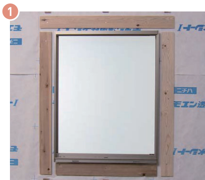
図1 胴縁の施工
