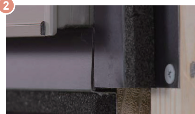
図3 鋼板下地材Ⅱの施工
