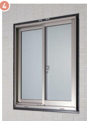
▲サッシ下は横勝ちでアルミ開口ベース材Iを留め付ける
