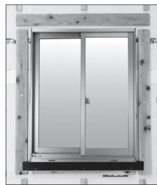
開口下に鋼板下地部材の取り付け
