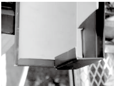
けらば水切110(85)軒先部の加工例
