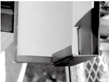
けらば水切110(85)軒先部の加工例
