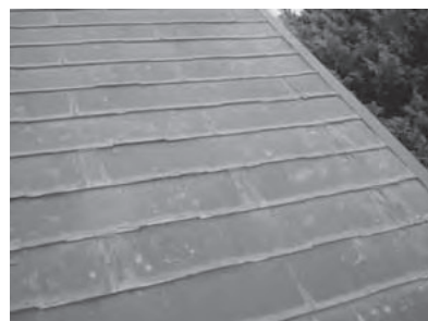
【屋根葺材の凍害】
