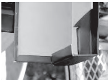
けらば水切110(85)軒先部の加工例
