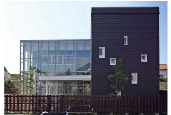
黒い外壁に使用されているのは、昭和電工建材株式のラムダ。ラムダムに設けられた窓は鉄砲間(矢間)を横している。
