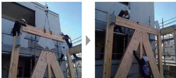
木造大断面工法では斜材が交差する部分の精度が重要。水平・垂直の誤差は3mm以内として施工されました。
