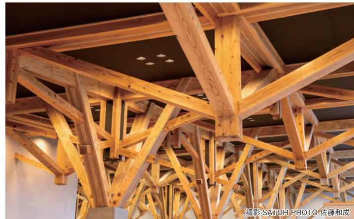
樹状V柱立体トラス部分とレシプロカル構造と張弦梁の部分により構成されている架構。メインとなるV柱や大梁でLVLを使用。単板積層材ならではの異なる木質の重なりが、ミルフィーユ状になりデザインの一部として機能しています。
