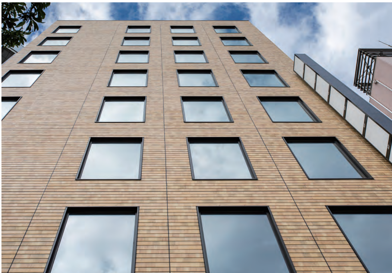
3～6階にはウッドシェイクⅡシュビネMGナチュラルを採用。外壁の幅や目地の幅などを細かく調整することで目地も含めた「グリッド」デザインとして意匠性の高いものに。
