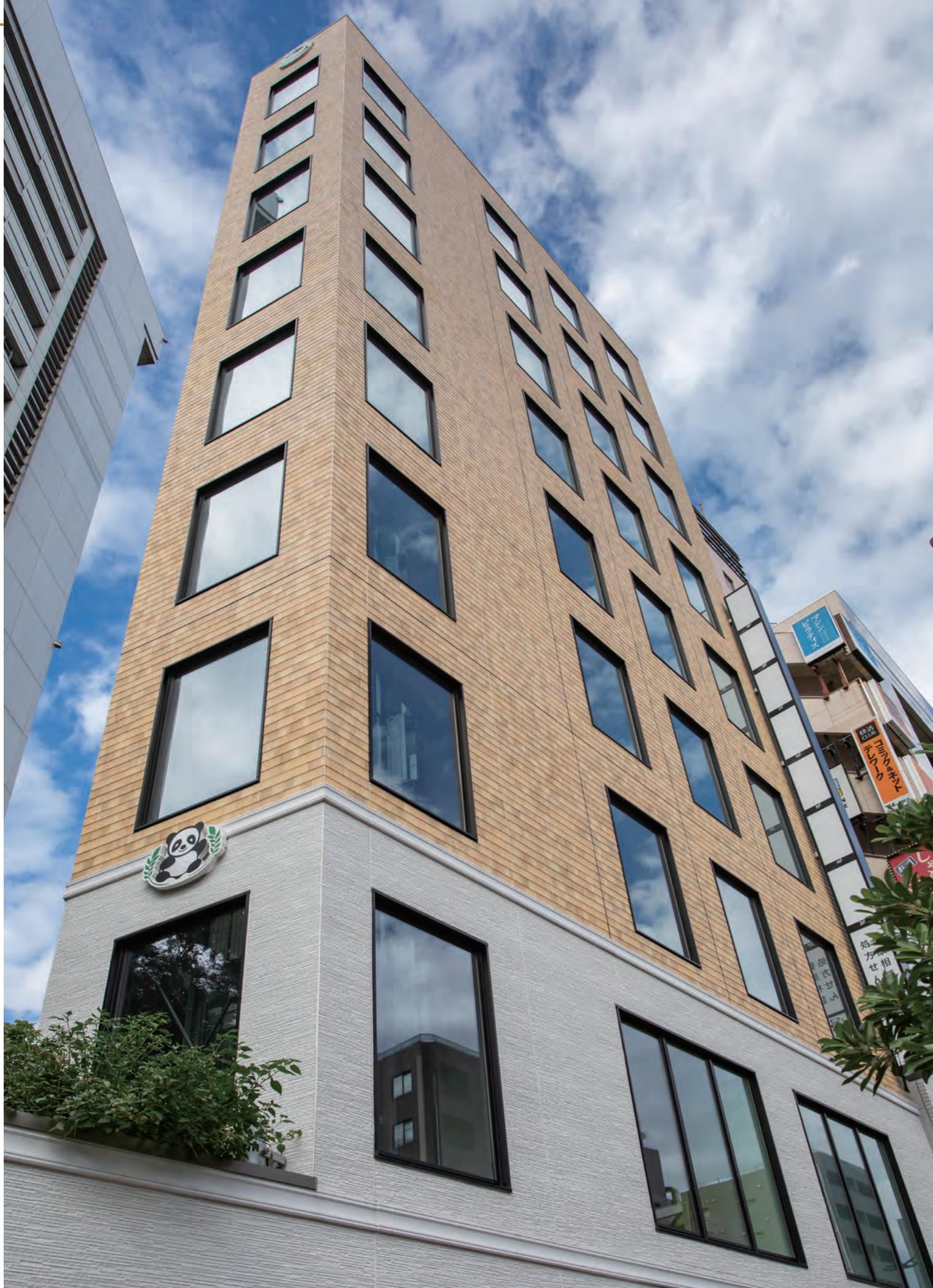
1～2階はクレミナウォール調リベルMGクリアホワイトⅡ、3～9階をウッドシェイクⅡシュビネMGナチュラルで張り分けられたトレディパーチェ王子。開口部の大きさを1～2階と3～9階で変えることで、外観デザインに心地よいリズム感を創出しています。
