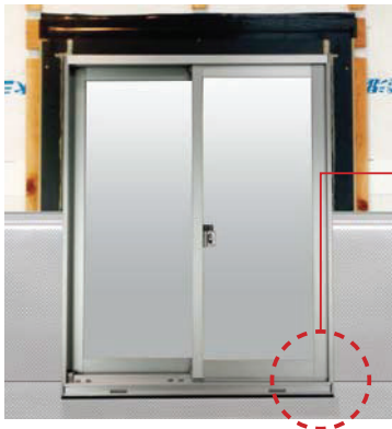
サイディングとサッシの隙間が小さくなるように施工
