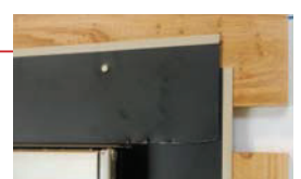
サッシ横に取り付けた部材の上に乗るように施工
