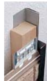
金具施工時の納まり (KA2088) イメージ
