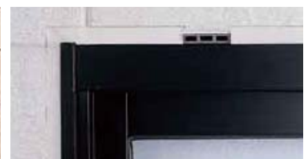
②シーリング施工後、モエン開口水抜き部材の養生テープをはがす。
