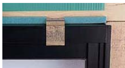
横張り金具工法の開口部上側モエン開口水抜き部材施工イメージ (FC100) ①モエン施工後にモエン開口水抜き部材・バックアップ材を施工する。 (写真はモエンをカットしてあります。)
