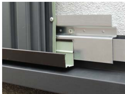
土台部には金属胴縁15接合部用(KN2060)を使用し施工してください。
