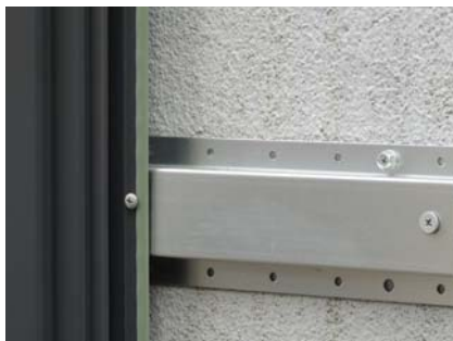
ステンレススチールネジ(JK1510)を使用し、センターサイディングを留め付けてください。
