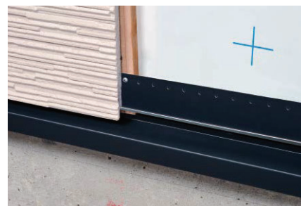
横張り金具工法の土台部 (FA150A)
