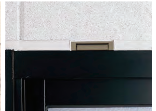
②シーリング施工後、モエン開口水抜き部材の養生テープをはがす。
