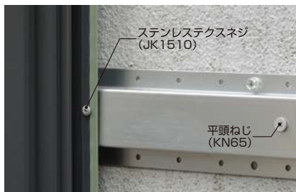
ステンレススネジ (JK1510) を使用し、センターサイディングを留め付けてください。
